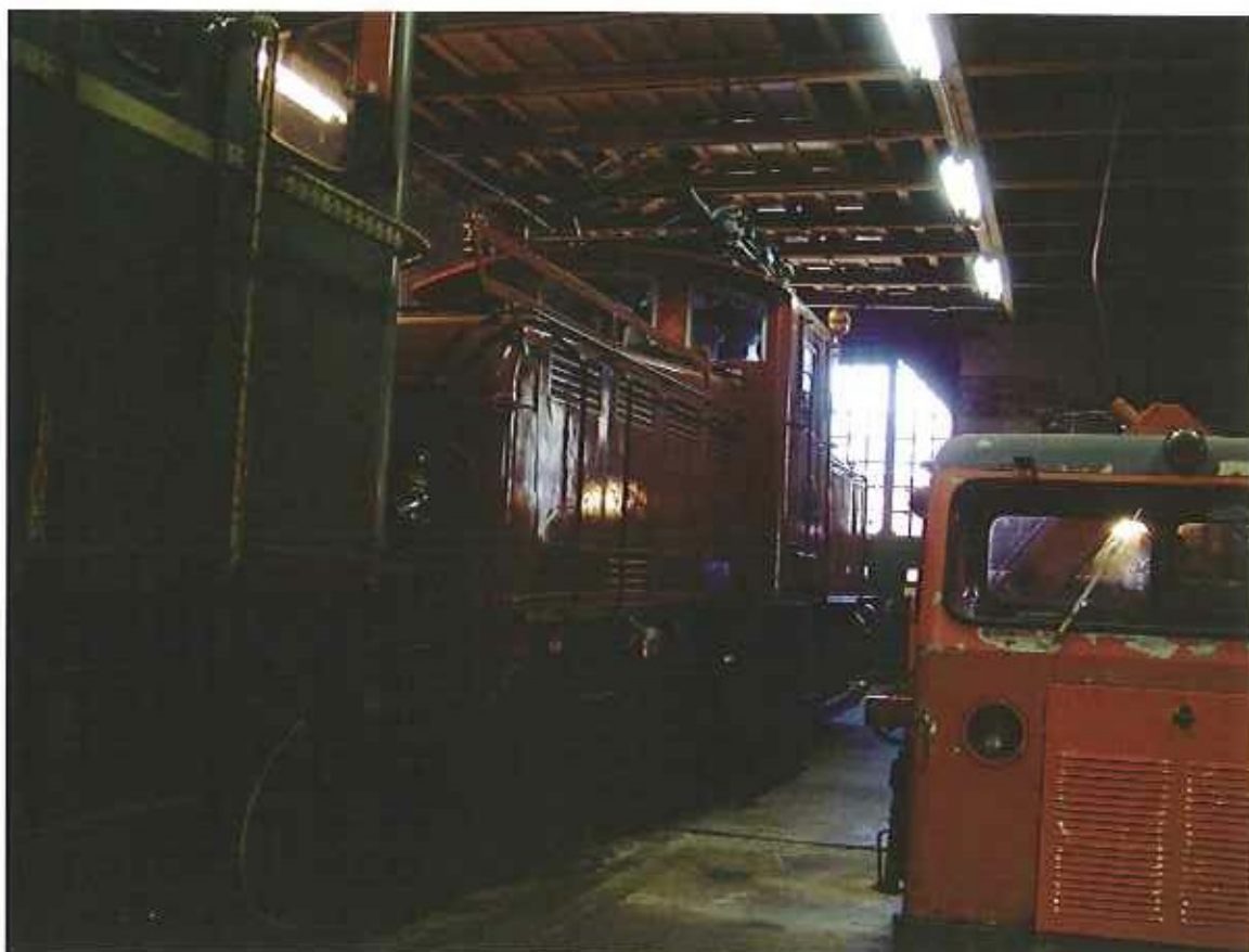
Interiör från det nybyggda fordonsmagasinet i Gammelstad utanför Luleå.
